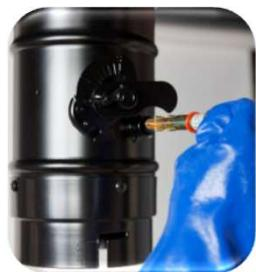
ダンパーからヒューズホルダーを取り外して、板ヒューズを取り外して汚れを拭き取る
